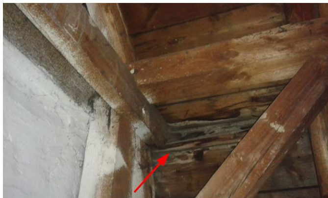
obr. /22/ Stopy zatékání na dřevěných prvcích krovu
