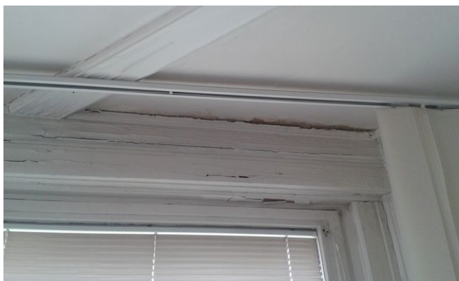
obr. /19/ Stopy zatékání a degradace oken navazujících konstrukcí
