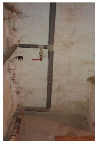
obr. /4/ Zvýšená vlhkost stavby v suterénu, tvorba výkvětů a opadávající omítka obr. /5/ Vlhké omítky ve sklepe
