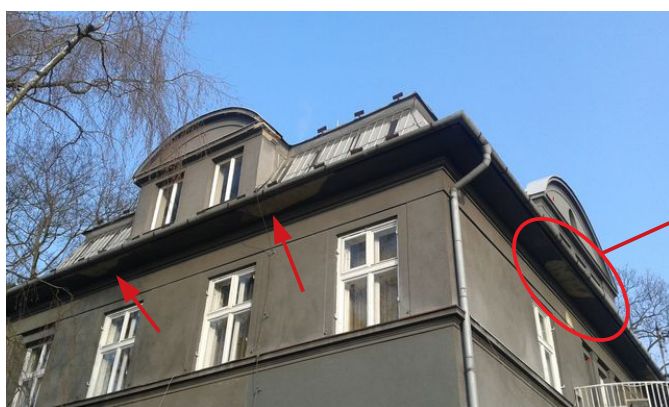
obr. /14/ Odpadávající omítka ze římsy pod střechou průběžně kolem celého objektu
