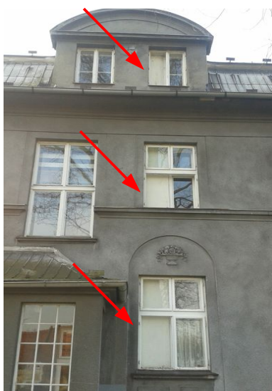
obr. /16/ Chybějící křídla oken
