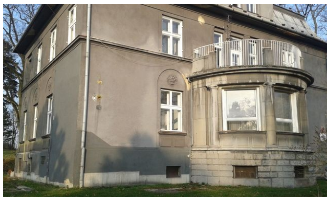
obr. /26/ Pohled na stopy zatékání v místě okapu terasy
