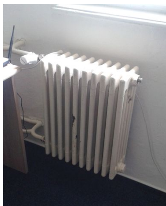
obr. /36/ Litinová topná tělesa
