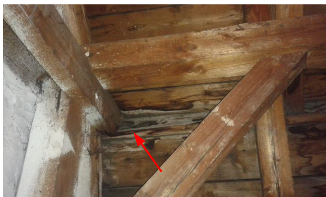
obr. /10/ Stopy zatékání na dřevěných prvcích krovu
