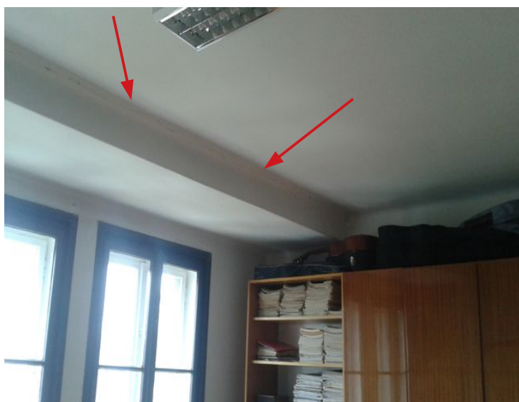
obr. /12/ Trhlina místě nosného překladu
