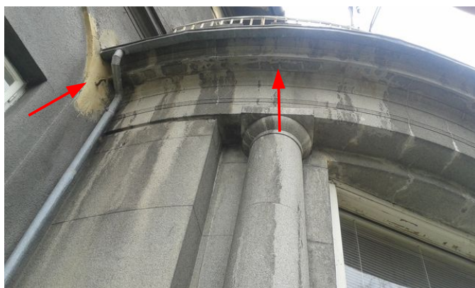
obr. /6/ Stopy zatékání na fasádě objektu
