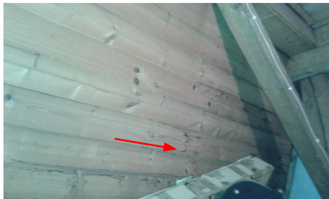
obr. /23/ Stopy zatékání na dřevěném bednění v podkroví objektu – sklad hudebnin
