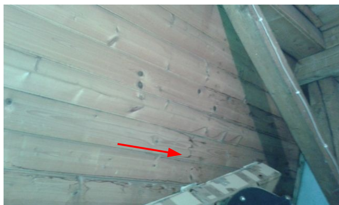
obr. /11/ Stopy zatékání na dřevěném bednění v podkroví objektu – sklad hudebnin
