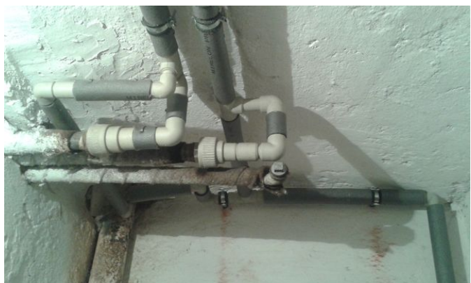
obr. /30/ Místo napojení nových rozvodů vodovodu na stávající ocelové trubky obr. /31/ Deformace potrubí vlivem nedostatečného kotvení
