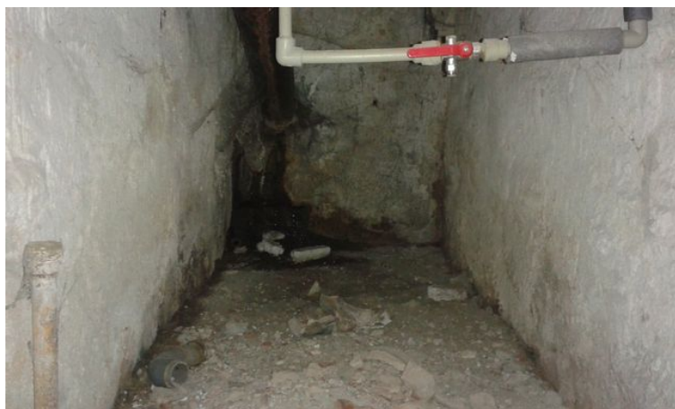
obr. /4/ Zvýšená vlhkost stavby v suterénu, tvorba výkvětů a opadávající omítka obr. /5/ Vlhké omítky ve sklepe
