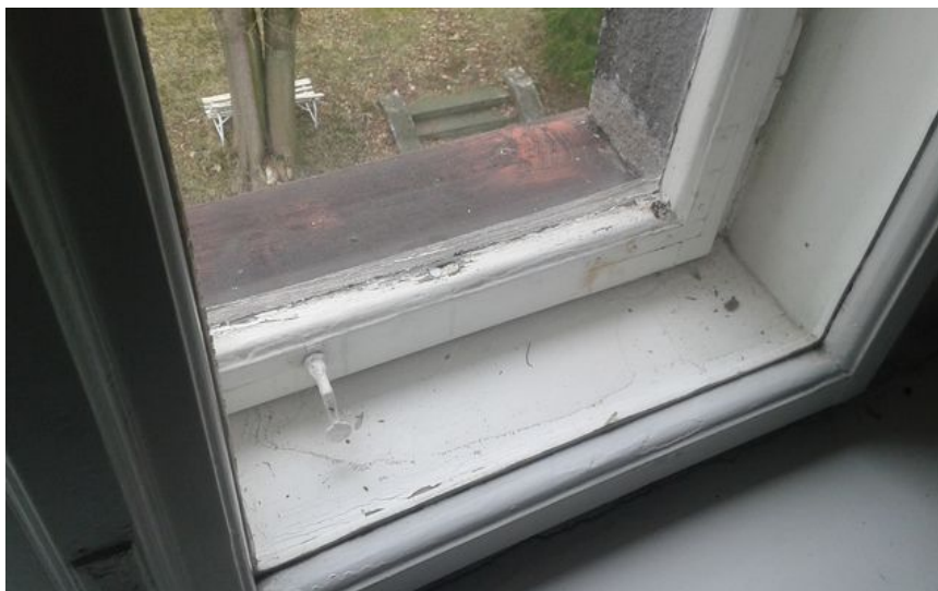
obr. /17/ Degradace nátěru kastlových oken
