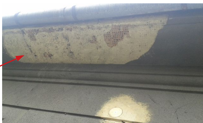
obr. /15/ Detail místa s odpadávající omítkou
