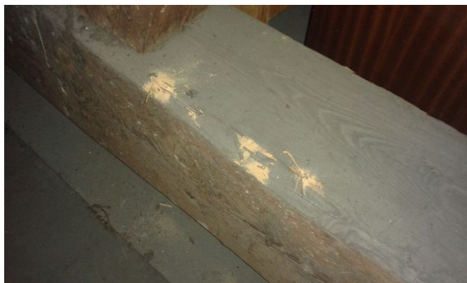
obr. /24/ Stopy napadení krovu dřevokazným hmyzem
