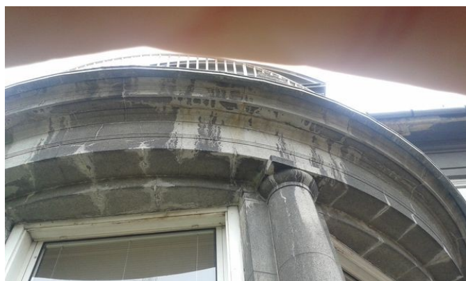
obr. /27/ Stopy zatékání v místě okapu terasy
