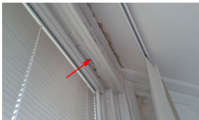
obr. /9/ Degradace výplní vlivem zatékání přes terasu na severovýchodní straně objektu
