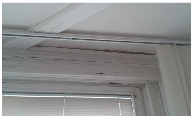
obr. /8/ Degradace výplní vlivem zatékání přes terasu na severovýchodní straně objektu
