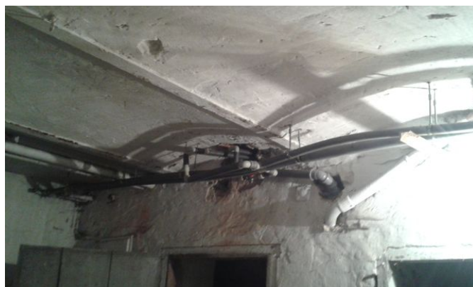
obr. /30/ Místo napojení nových rozvodů vodovodu na stávající ocelové trubky obr. /31/ Deformace potrubí vlivem nedostatečného kotvení
