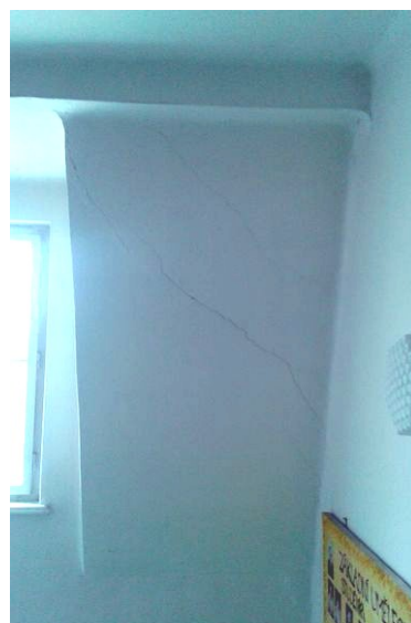
obr. /13/ Vlasečnicové trhliny na omítce v prostoru schodiště
