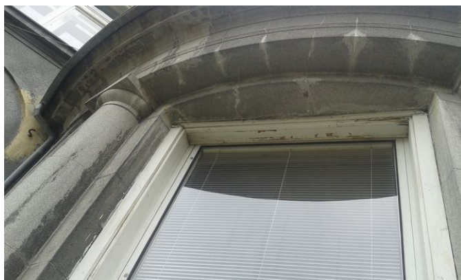
obr. /18/ Stopy zatékání po nadpraží zdvojených oken na severovýchodní straně objektu
