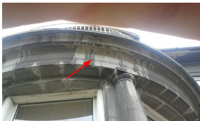
obr. /7/ Stopy zatékání na fasádě objektu
